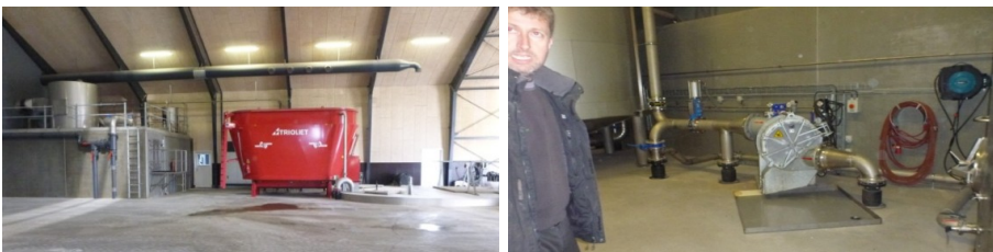
Billede 4. Doseringskøle 2 til vanskelige masser, en foderblander. Bemærk at den er overdækket Støckler) med hydraulisk styret dæksel. Til venstre første del af BBK anlægget med muslingeskaller til svovlbinding og rensning af ventilationsluft. (Foto: M. Støckler).
